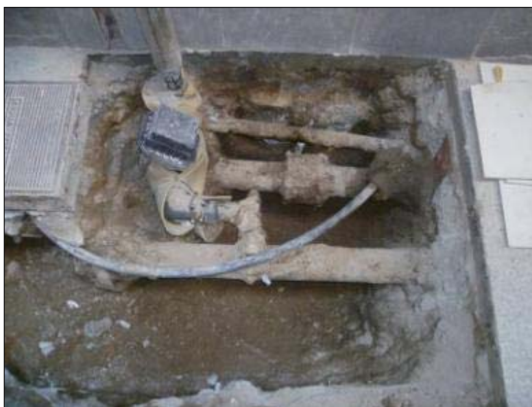
Fotografia 12. Sondeig realitzat front de la finca Arc de Santa Eulàlia núm. 1 on s'ha portat la nova línia elèctrica
